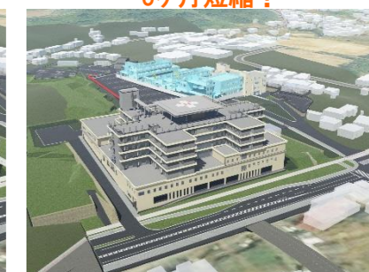
STEP7: 令和6年1月下旬頃 既設病院解体 ～駐車場外構工事中
