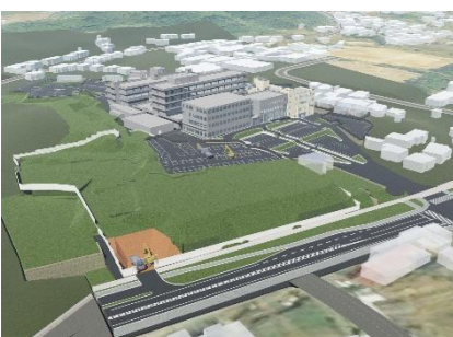
STEP1: 令和3年4月上旬頃 準備工事: 仮囲い・既存駐車場解体・前面道路側ゲート作成
