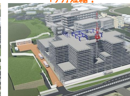
STEP6: 令和5年2月中旬頃 躯体上棟～ヘリポート建方工事中
