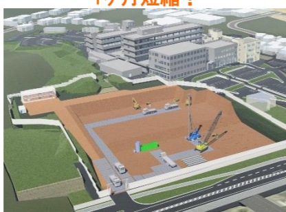
STEP2: 令和3年8月中旬頃 N工区: 1次造成中 S工区: 山留完了～既成杭工事中
