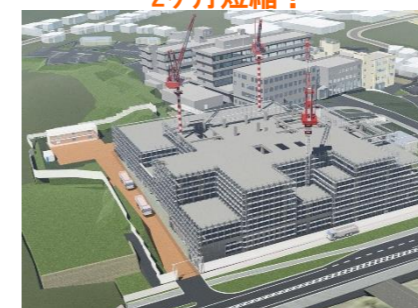
STEP5: 令和4年10月上旬頃 上階躯体工事 3階立上り4階スラブ
