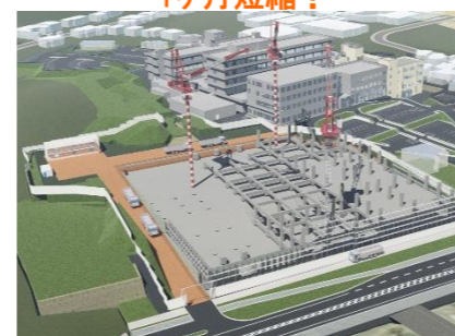
STEP4: 令和4年5月上旬頃 地下躯体工事 N工区: 地下1階立上り S工区: 免震上部基礎
